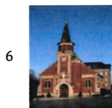
L'église de la Nativité de la Sainte Vierge L'église est un édifice en briques rouges et pierre calcaire, au clocher élancé coiffé d'une flèche d'ardoise.
