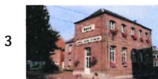
La mairie Le bâti en briques rouges et à l'architecture symétrique, illustre le style traditionnel des mairies du nord de la France.
